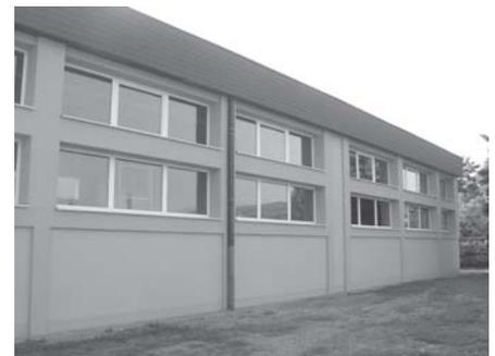
Der Hauptschulturnsaal wurde im Sommer 2005 mit einem Vollwärmeschutz versehen. Die Glasbaufenster wurden ausgetauscht und die Heizungsrohre entlang der Wände wurden mit neuer Wärmeisolierung ummantelt. Diese Maßnahmen brachten bereits im ersten Winter enorme Einsparungen bei den Energiekosten. Sie betragen 15 %. Dies trotz eines sehr strengen und auch sehr langen Winters den wir sicherlich noch alle in Erinnerung haben.
